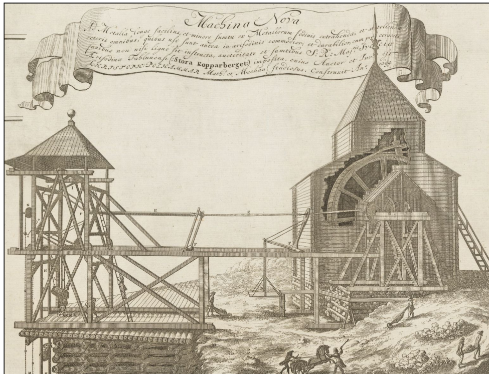
Illustration 1.28 Polhems uppfodringsverk Machina Nova vid Stora kopparberget i Falun, mer bekant som Blankstötsverket, stod klart i februari 1694 och kom att effektivisera transporten av malm till markytan. Maskineriet ersatte tidigare hissanordningar med rep av dyra oxhudar. Förlagan till Machina Nova utgjordes av en modell som Polhem (i olika versioner) förevisat för Bergskollegium och ”konung Carl XI, som var en god kännare, så nådigt ansedt, at han tilldelade Upfinnaren 500 Daler Silfverm. årligen lön såsom Bergs-mechanicus”, som det hette i Vetenskapsakademien ämminnelsetal för Polhem 1753. Förarbetet till gravyren – som ingår i Erik Dahlberghs Suecia antiqua et hodierna (1715) – tecknades av modellbyggare Samuel Buschenfeldt.
