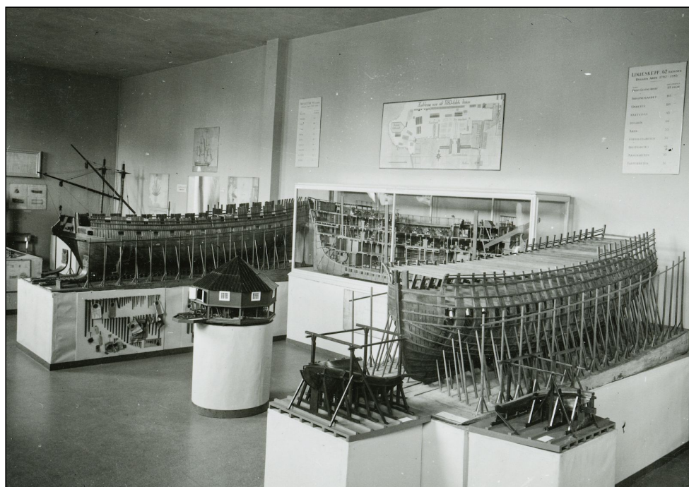
Illustration 1.40 "Karlskrona varv vid 1780-talets början" – när Sjöhistoriska museet i Stockholm öppnade 1938 innehöll basutställningen självfallet en avdelning om örlogsbasen Karlskrona. På fotografiet syns till höger en modell av ett tidstypiskt linjeskepp, de största krigsfartygen under segelflottornas tid. I Karlskrona byggdes 1782–83 tio fregatter (till vänster) och tio linjeskepp, alla med 62 kanoner. Modellen i mitten föreställer ett sliphus – som baserar sig på originalmodellen, Sliphuset med bår och Swarf Inrättning, enligt en förteckning från 1804.
