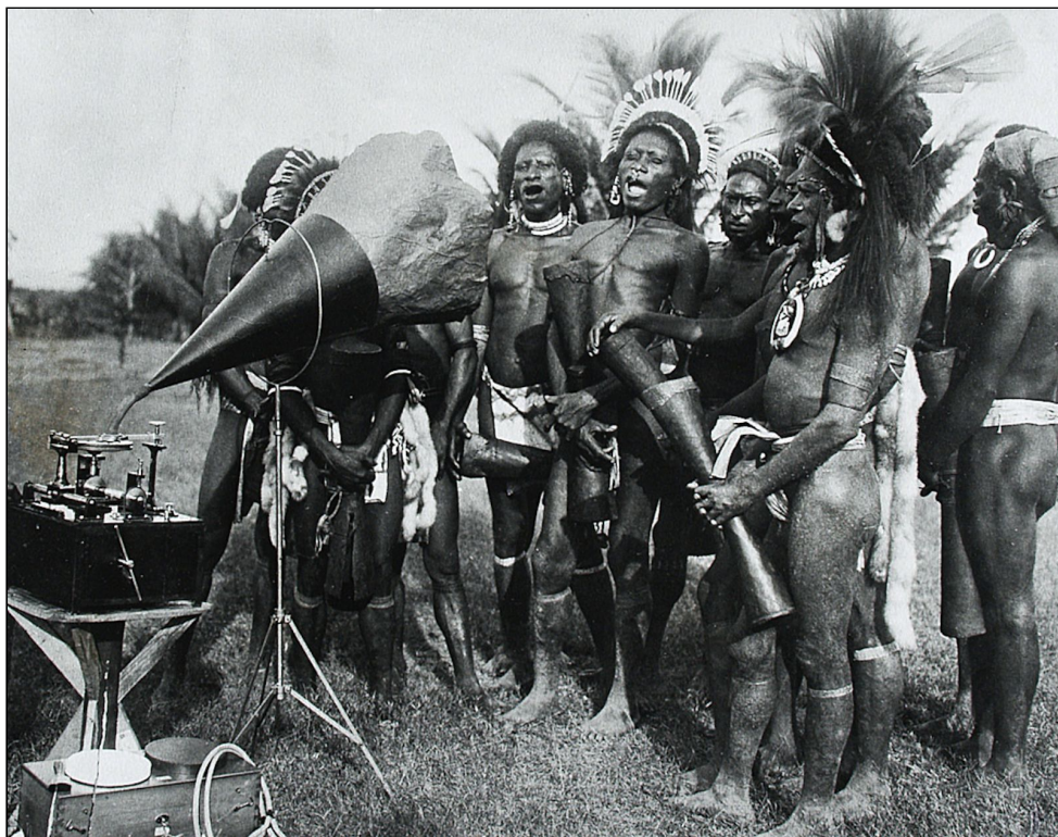
Illustration 4.15 "Tonaufnahmen mit dem Archiv-Phonographen bei den Baifa-Papua" – fotograferad av Rudolf Pöch i Tyska Nya Guinea 1904. Noterbart är att fonografrattens upptagningsvolym utökats med ett palmblad för att bättre registrera sång och trummor. Fotografi från Weltmuseum Wien.
