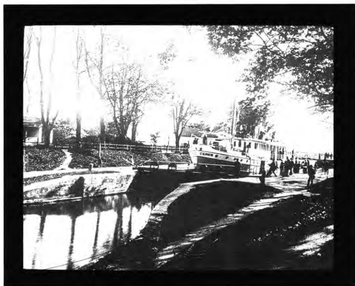
Illustrationer 30. och 31. "Motala – parti af sluss" och "Borens-hults slussar" ur bildserien Sverige – producerad av Hasselblads fotografiska AB, Göteborg, vid mitten av 1890-talet. Jämför man de bägge skioptikonbilderna med senare ljusbilder från Hasselblad, till exempel den ovan från Trollhättan, ges en antydan om att den bildestetik Hasselblad nyttjade innan 1900 förändrades efter sekelskiftet. En tidigare strävan att fotografiskt fånga tidstypiska svenska miljöer ersattes och förskjöts kring 1900 i en mer lukrativ riktning där rumstypiska miljöer fokuserades, motiv som hade fördelen att inte bli daterade lika snabbt. Nordiska museet.
