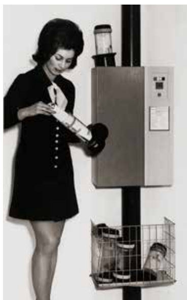
Inte utan viss stolthet annonserade bolaget el-centralen H. Schulze AB i januari 1971 i SVD att man installerat ett helautomatiskt rörpostsystem i det nya riksdagshuset – som grafiskt presenterades i DN (8/1) strax före dess invigning. El-centralen var generalagent för den tyska firman Aeropost som byggt Rohrpostsysteme alltsedan mitten av 1950-talet. Det är ett bolag som fortfarande existerar, men numera under namnet Aerocom. Fotografiet av kvinnan i tidstypisk sextiotalsdress återfinns på firmans hemsida.
